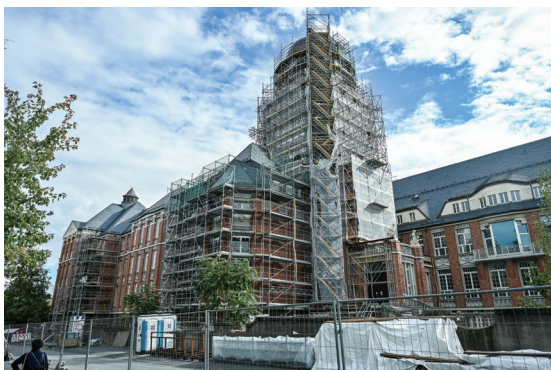
相片9：德勒斯登工業大學內之修復現場，其一，施工圍籬為半封圍式，且防塵網僅設置於鷹架上之局部位置。
