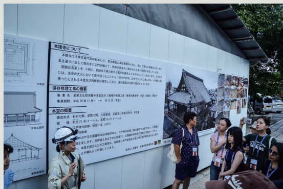
相片1：京都本隆寺金堂修繕工地，由京都府聘僱的現場建築師親自導覽說明。
