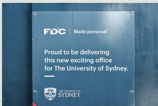
相片6：雪梨大學校內之施工現場，施工圍籬上的口號：「Proud to delivering this new exciting office for The University of Sydney」。
