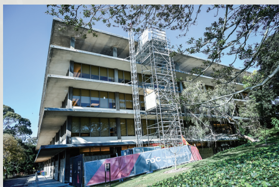
相片5：雪梨大學校內之施工現場。
