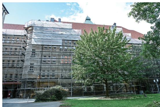
相片10：德勒斯登工業大學內之修復現場，其二，修復現場未設置圍籬，且防塵網僅設置於鷹架上之局部位置。
