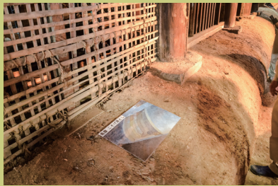
相片4：京都本隆寺金堂修繕工地，龜腹表面粉刷層全數敲除後之樣貌，龜腹上放置照片以說明粉刷層解體時發現的層位。
