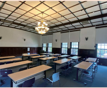
圖4：博物館大會議室，天花板應消防局要求將安裝防煙垂壁，其安裝需符合可逆性原則。
