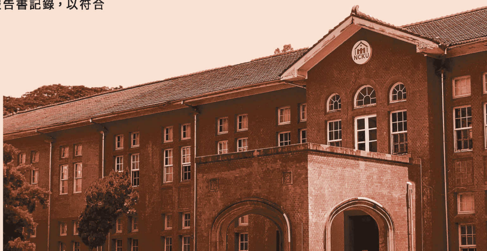
圖3：十三溝面磚外牆是博物館的重要建築特徵之一，若非必要，不宜恣意將面磚敲除，應以最小干預原則為之。
